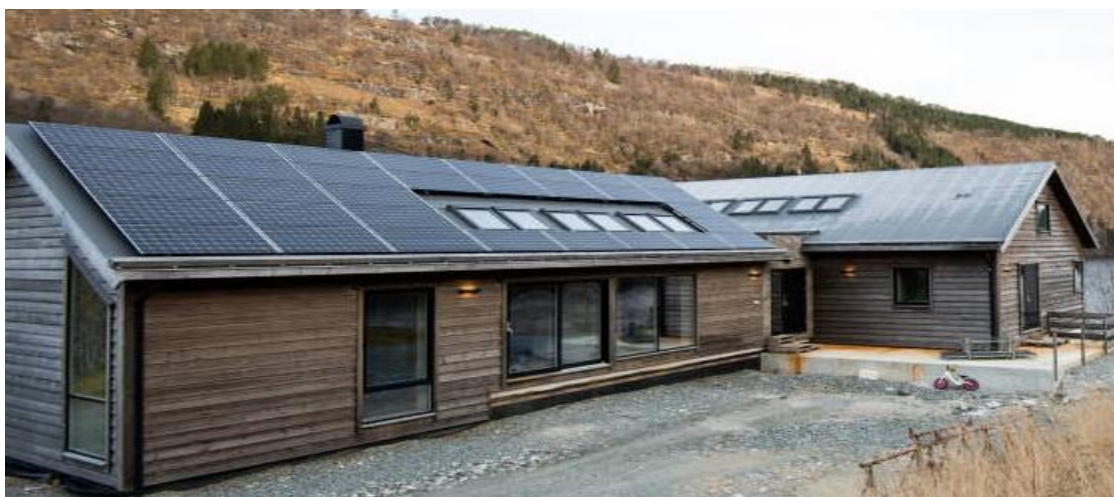
Figur 1 – Bjørvik Miljøhus, Solcelleanlegg
